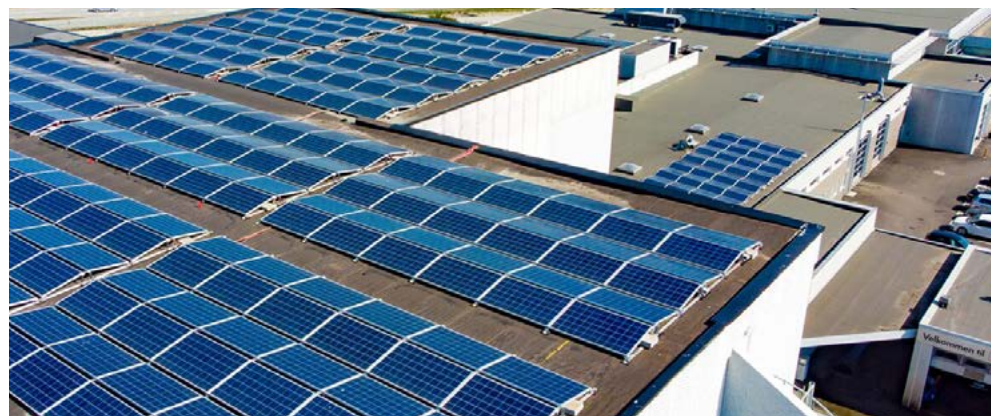
Møller Bil Forus har installert solcelleanlegg med en beregnet årsproduksjon på 210 000 kWh. Det tilsvarer gjennomsnittsbehovet for rundt 13 norske husstander i året.
